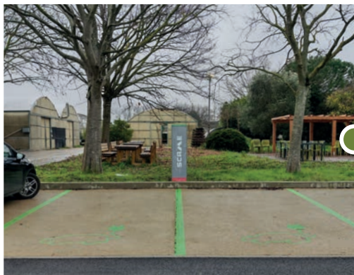
RIMINI Realizzazione infrastruttura di ricarica per veicoli elettrici presso sede Rimini
