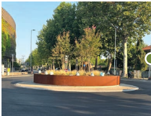
RIMINI Realizzazione della nuova rotatoria tra via Flaminia, Dalla Chiesa e Fada
