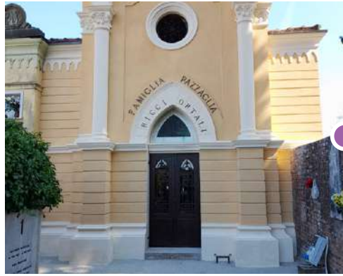
Ristrutturazione Cappellina Famiglia Ricci - Ortali. Cimitero Centrale di Santarcangelo di Romagna
